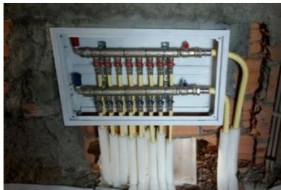
شکل ۵۹-۱ جعبه کلکتور سیستم گرمایش رادیاتور
