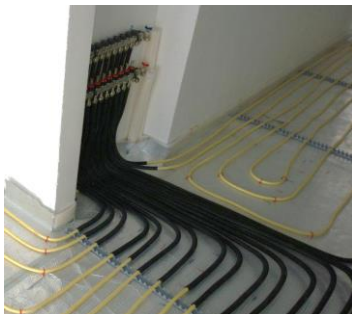
شکل ۲-۲۵ عایق‌کاری لوله‌های گرمایش از کف در نزدیکی کلکتور رفت و برگشت
