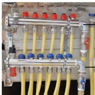
شکل ۲-۱۲ استفاده غیر مجاز اتصالات گالوانیزه در سیستم گرمایش از کف
