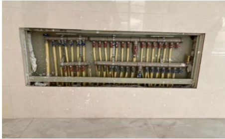
شکل ۵۷-۱ اجرای جعبه کلکتور (استفاده از سه راه کلکتور جهت آبرسانی بهتر در کلکتور با انشعابات زیاد)
