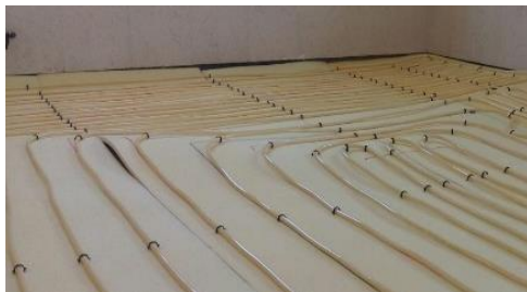
شکل ۷-۲ نمونه‌ای از تراز نبودن سطح و ایجاد برآمدگی
