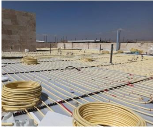
شکل ۲-۴۸ اجرای سیستم گرمایش از کف به عنوان ذوب برف بر روی پشت بام
