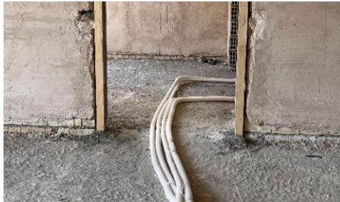
شکل ۲۷-۱ عبور صحیح لوله از ورودی یک بخش
