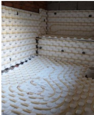
شکل ۲-۴۹ اجرای سیستم گرمایش از کف در حمام ترکی
