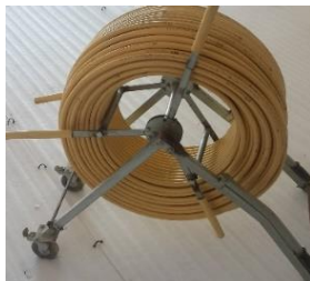
شکل ۲-۲۰ استفاده از رول باز کن برای اجرای لوله در گرمایش از کف
