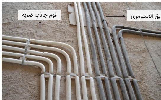
شکل ۱-۳۲ استفاده از عایق حرارتی (الاستومری) و فوم جاذب ضربه
