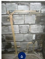
شکل ۱-۴۱: استفاده صحیح از صفحه نصب (۱) صفحه نصب ۶۳ mm (شیر تکی)، (۲) صفحه نصب ۱۵۳ mm (شیر مخلوط)، (۳) صفحه نصب ۲۸۰ mm (روشویی)، (۴) صفحه نصب قوس‌دار، (۵) صفحه نصب ۵۰۰ mm (حواله خشک‌کن) و (۶) صفحه نصب زیر پکیج
