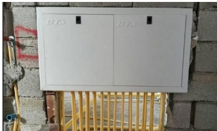
شکل ۵۸-۱ جعبه کلکتور BTS
