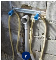
شکل ۱-۴۰: الف) صفحه نصب تک، ب) صفحه نصب دو اتصال (۱۵۳mm ، ۲۸۰ و ۵۰۰)، ج) صفحه نصب قوس‌دار، د) صفحه نصب زیر پکیج
