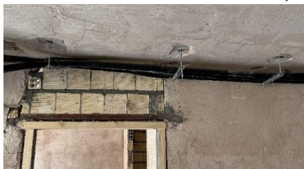
شکل ۲۹-۱ استفاده از بست مناسب برای نگهداری لوله
