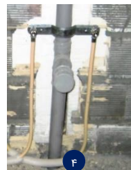
شکل ۱-۴۱: استفاده صحیح از صفحه نصب (۱) صفحه نصب ۶۳ mm (شیر تکی)، (۲) صفحه نصب ۱۵۳ mm (شیر مخلوط)، (۳) صفحه نصب ۲۸۰ mm (روشویی)، (۴) صفحه نصب قوس‌دار، (۵) صفحه نصب ۵۰۰ mm (حواله خشک‌کن) و (۶) صفحه نصب زیر پکیج
