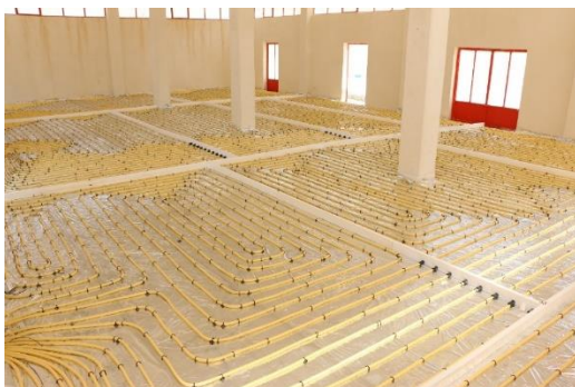
شکل ۴۷-۲ اجرای سیستم گرمایش از کف در سوله صنعتی
