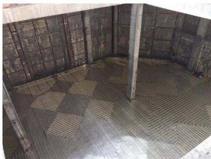
شکل ۴۶-۲ اجرای سیستم گرمایش از کف ترموستاتیک در مسجد و حسینیه
