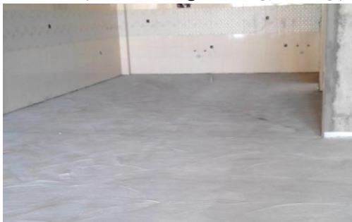
شکل ۶-۲ سطح صاف، تراز و عاری از هرگونه نخاله ساختمانی و آماده شده برای اجرای گرمایش از کف
