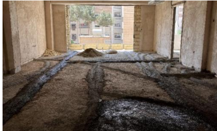
شکل ۴۶-۱ پوشاندن لوله‌ها با ملات پس از اتمام تست و تأیید مهندس ناظر برای جلوگیری از آسیب دیدگی
