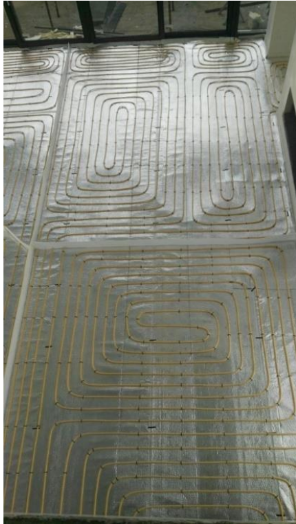
شکل ۵۲-۲ اجرای سیستم گرمایش از کف برای ساختمان با سقف بلند
