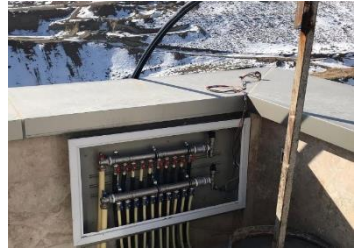
شکل ۲-۴۸ اجرای سیستم گرمایش از کف به عنوان ذوب برف بر روی پشت بام
