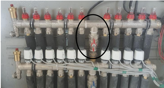
شکل ۲-۸ استفاده از سه راهی کلکتور در وسط کلکتور برای آب ورودی و خروجی اصلی (کلکتور برگشت بالا باید بسته شود)
