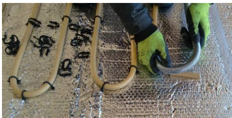
شکل ۲-۲۱ استفاده از فنر روکار برای خم کردن لوله
