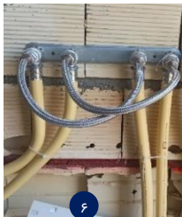
شکل ۱-۴۱: استفاده صحیح از صفحه نصب (۱) صفحه نصب ۶۳ mm (شیر تکی)، (۲) صفحه نصب ۱۵۳ mm (شیر مخلوط)، (۳) صفحه نصب ۲۸۰ mm (روشویی)، (۴) صفحه نصب قوس‌دار، (۵) صفحه نصب ۵۰۰ mm (حواله خشک‌کن) و (۶) صفحه نصب زیر پکیج
