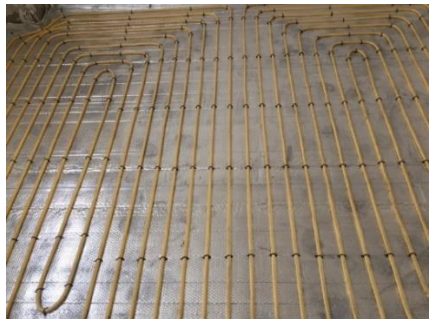
شکل ۲-۲۷ اجرای صحیح استفاده از بست خاردار
