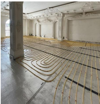
شکل ۵۰-۲ اجرای سیستم گرمایش از کف در ویلا
