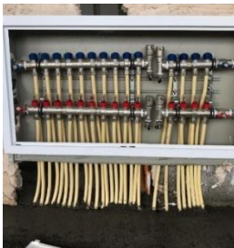
شکل ۲-۴۴ اجرای جعبه کلکتور گرمایش از کف
