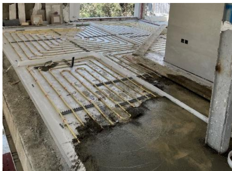
شکل ۵۱-۲ بتن ریزی سیستم گرمایش از کف
