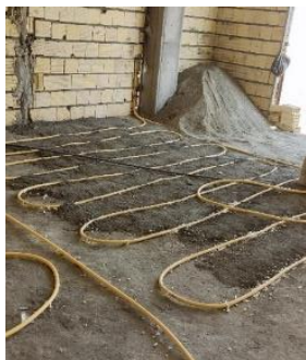
شکل ۲-۲۹ اجرای غلط - استفاده از لوله‌های سیستم گرمایش رادیاتور به عنوان گرمایش از کف
