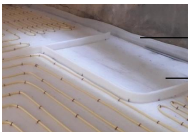
شکل ۲-۱۵ عایق نمودن محیط‌های بدون گرمایش برای جلوگیری از اتلاف حرارت و آسیب دیدن بتن و تجهیزات
