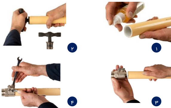
شکل ۱-۲۳ نحوه اجرای اتصالات کلمپی
