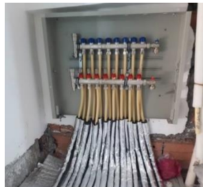
شکل ۲-۴۴ اجرای جعبه کلکتور گرمایش از کف
