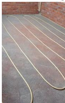
شکل ۲-۲۹ اجرای غلط - استفاده از لوله‌های سیستم گرمایش رادیاتور به عنوان گرمایش از کف
