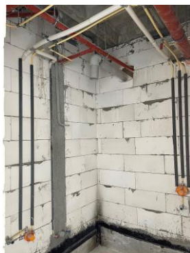
شکل ۵۴-۱ لوله کشی زیر سقفی با شیرآلات توکار
