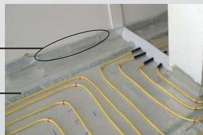
شکل ۱) استفاده از ورق حباب‌دار متالایز برای عایق کف
