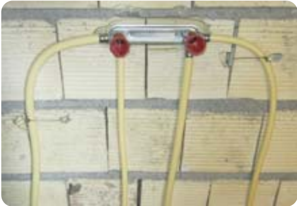
✓ استفاده از سه راهی تبدیل 20 \times 1/2 \times 20 (سمت راست) و 20 \times 1/2 \times 16 (سمت چپ)
