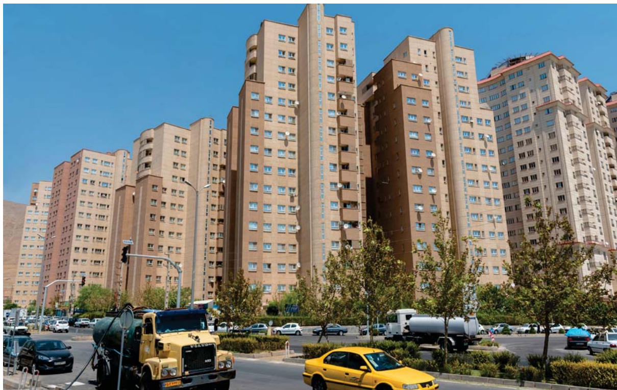
مجتمع مسکونی شهید صیاد شیرازی | تهران (منطقه ۲۲) | ۸ بلوک | ۱۹ طبقه | ۹۱۲ واحد
